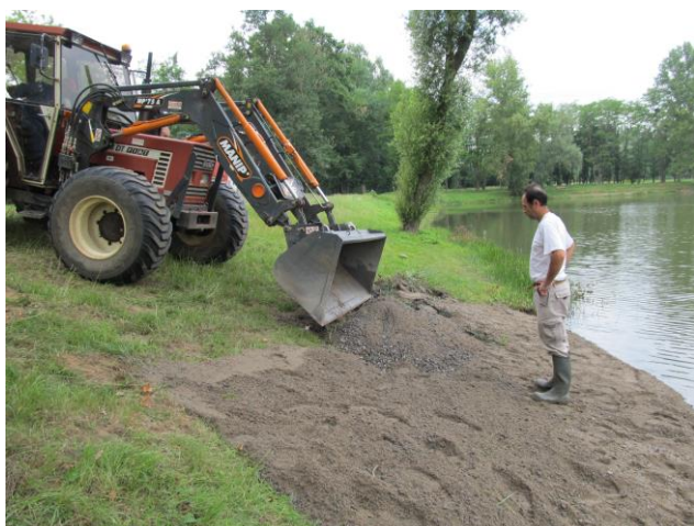
Dépôt de mélange sablo-graveleux
