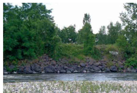
Les enrochements, des aménagements qui cloisonnent le lit de la rivière et empêchent la dynamique fluviale de s'exprimer.
