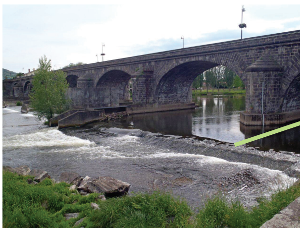
Le seuil de Pont-du-Château avant et après travaux.
