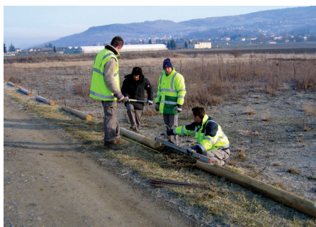
Pose de lisses en bois au Sail par les chantiers d'insertion de Gergovie Val d'Allier Communauté.
