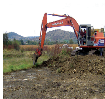
Suppression de remblais sur le pré salé du Sail à Mirefleurs.
